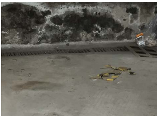
危废仓库导排沟
